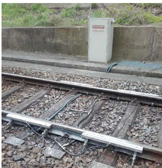
Abb. 3-5: SKK bei MQ1 – Übersicht des montierten Anlagenkastens inkl. Konditionierleisten
